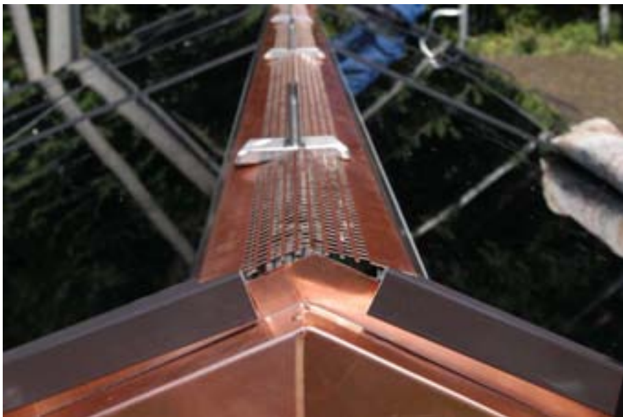
Detail der Firstentlüftung
