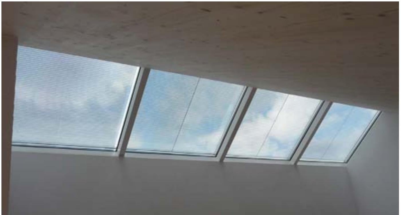
Innenansicht der transparenten Module des Oblichts
