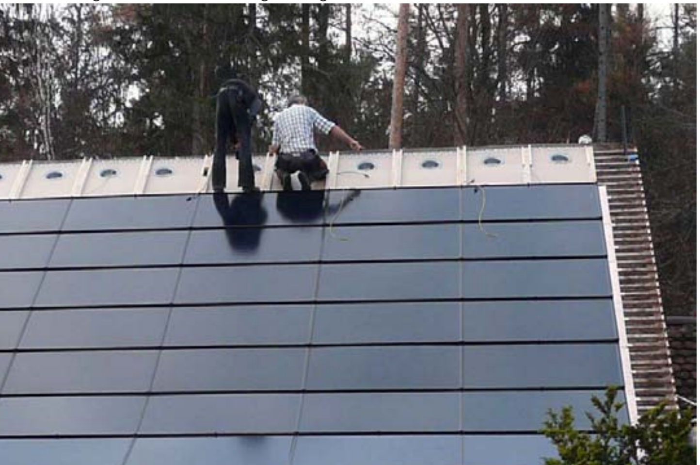
gut sichtbar die Ansaugöffnungen am oberen Rand
