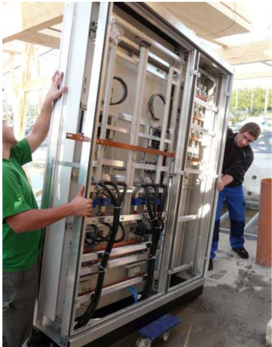
Der Schaltschrank mit den Energiezählern wird montiert
